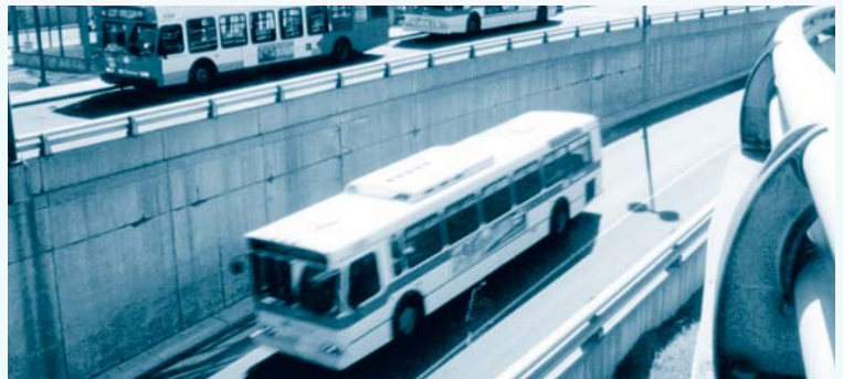
La station du Transitway au centre commercial St. Laurent à Ottawa
